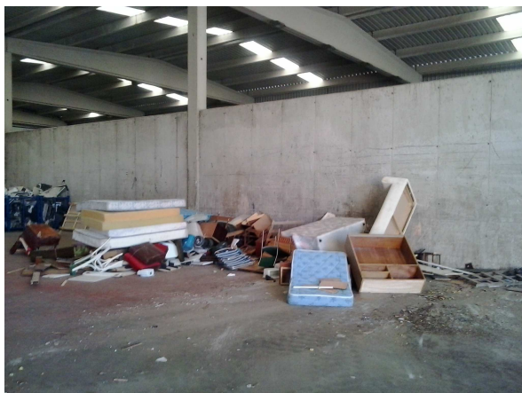
Almacenamiento de residuos voluminosos.
